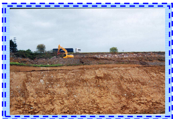
FOTO 33. Taludes que se deberían reforestar al finalizar las obras en la A-8.
